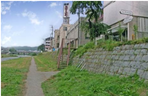
石積階段設置前
