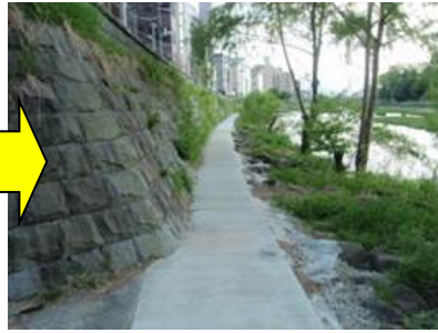
散策路設置後
