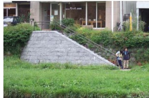
石積階段設置後
